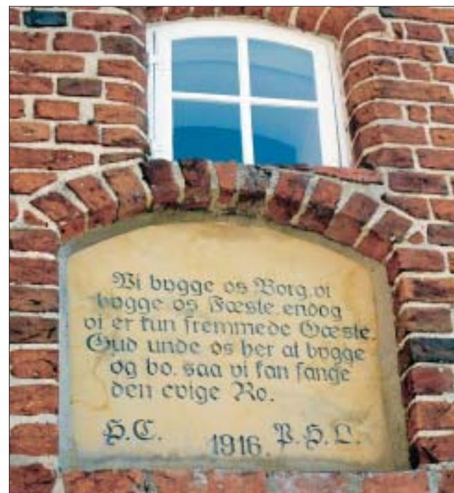
Da kammerherre Holger Collet i 1916 købte Katholm Gods, fik han indgraveret dette vers over indgangen til det sydøstlige tårn. Foto: Tommy Jervidal
